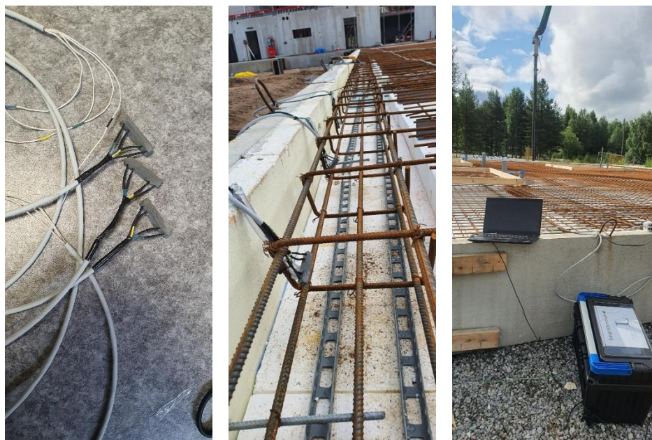
Figur 13. Installation av SmartCemHumid-systemet på en betongplatta på byggarbetsplatsen.
