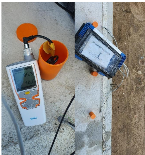
Figur 14. Visala fuktmätning med borrhålsmetoden
